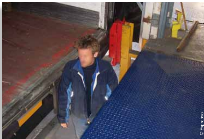
Exemple de butoirs de 0,50 m ménageant un espace de sauvegarde
