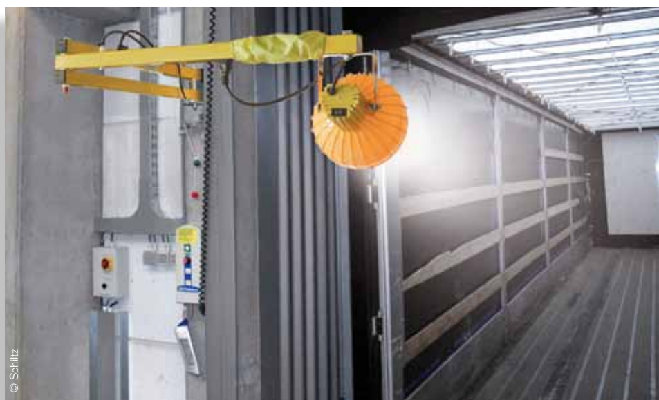
Spot intégré au quai
