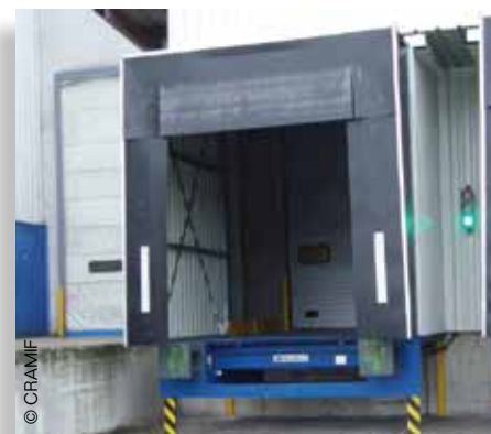
Tunnel de transbordement avec butoirs à 0,50 m
