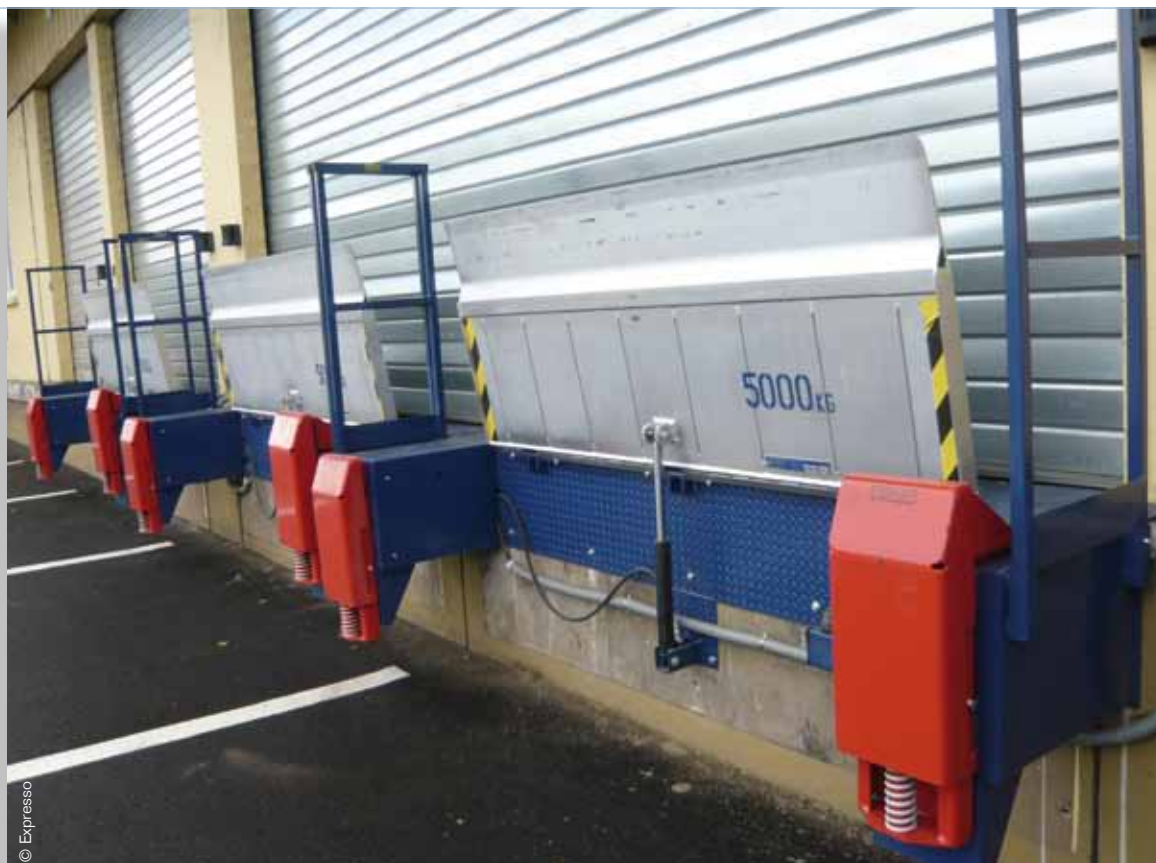
Exemple de pont de liaison sur quai (avec vérin, butoirs de 0,50 m et garde-corps)
