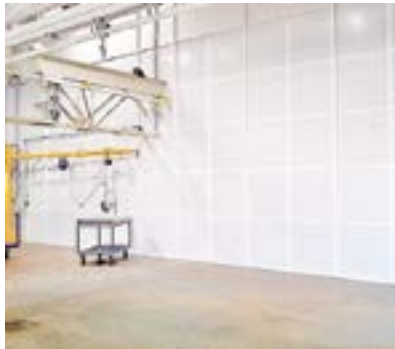
Cloison absorbante (isolation phonique)
