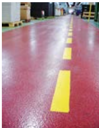
Résine époxy plus quartz coloré chiné Allée de circulation antidérapante en atelier de montage
