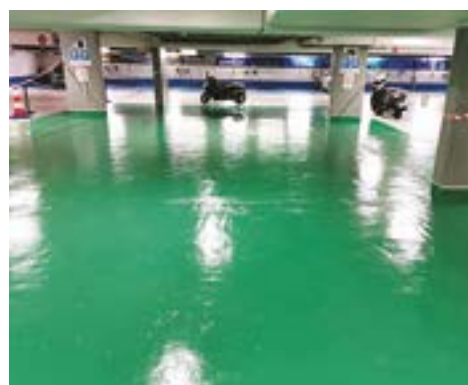
Application résine et marquage au sol intérieur
