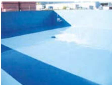
Stratifié époxy plus fibre de verre Bassin de récupération des eaux industrielles avant traitement
