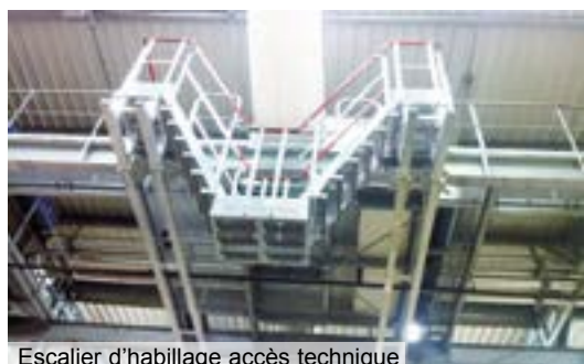
Escalier d'habillage accès technique
