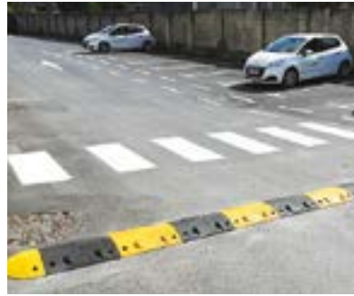
Pose de ralentisseurs VL et PL
