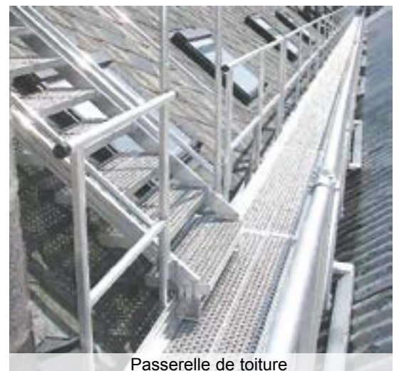
Passerelle de toiture
