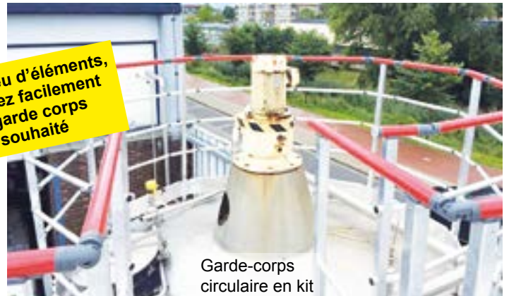
Garde-corps en station de traitements des eaux
