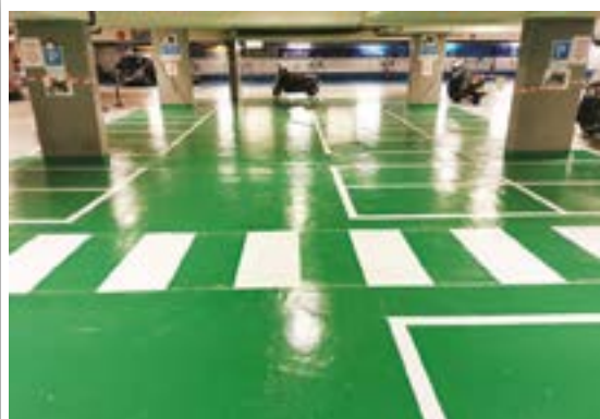
Application résine et marquage au sol intérieur
