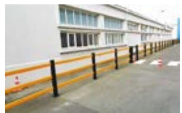
Pose de barrière de sécurité et de marquage industriel
