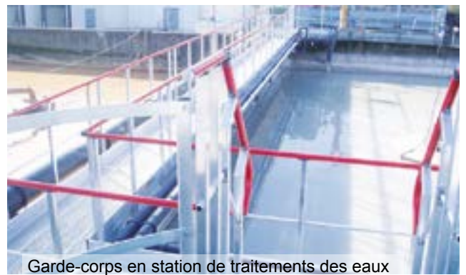
Garde-corps en station de traitements des eaux
