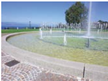
Etanchéité en résine polyurée Bassin d'agrément sur parking public
